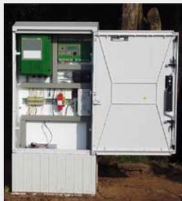
Armario de distribución con gestor de estación para el cálculo automático del caudal
